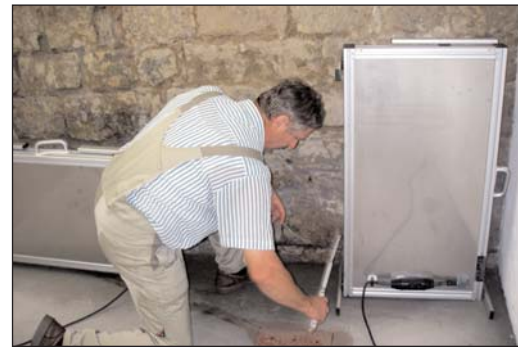
Trocknen von Gebäuden
